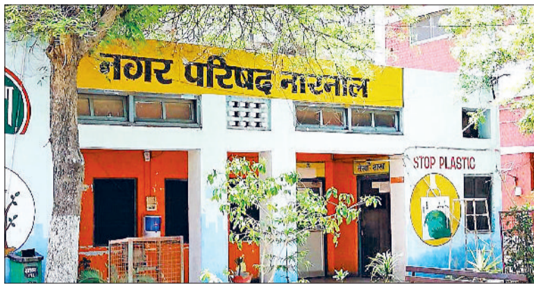
नारनौल। नगर परिषद भवन।
